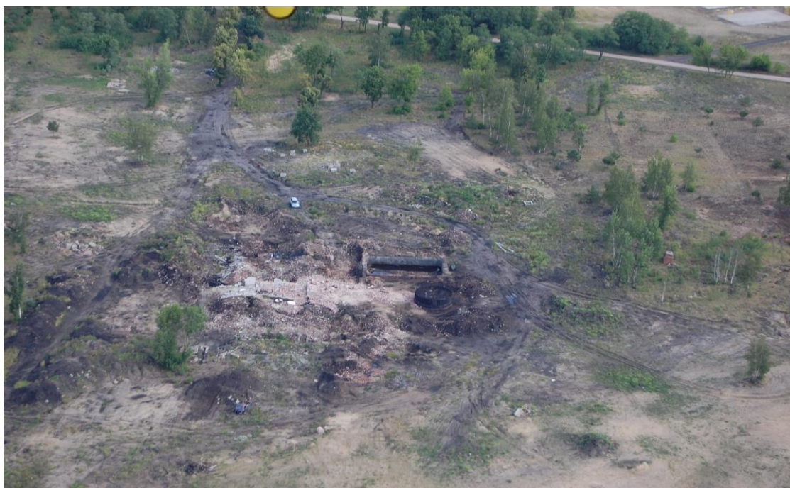
Ryc. 10 Obszar dawnej Nasycalni Podkładów Kolejowych – widok z góry[1]
